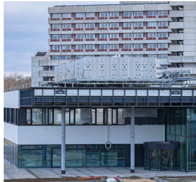
Eingangsbereich mit Drehtür, Altbau im Hintergrund
